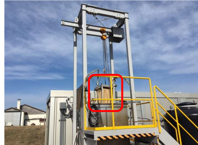
UF膜モジュールの吊上げ点検実施
