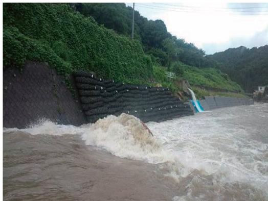
河川の災害における護岸の仮復旧
