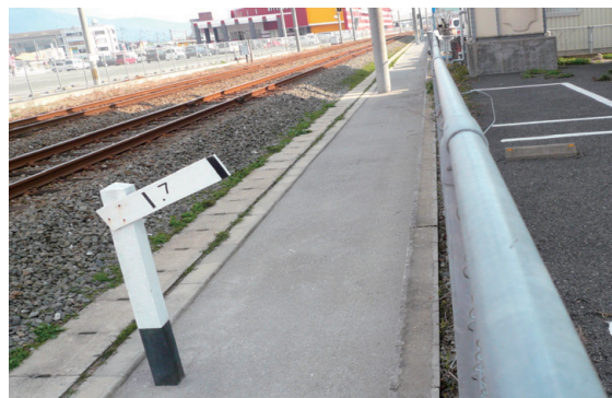
簡易舗装（防草対策）
