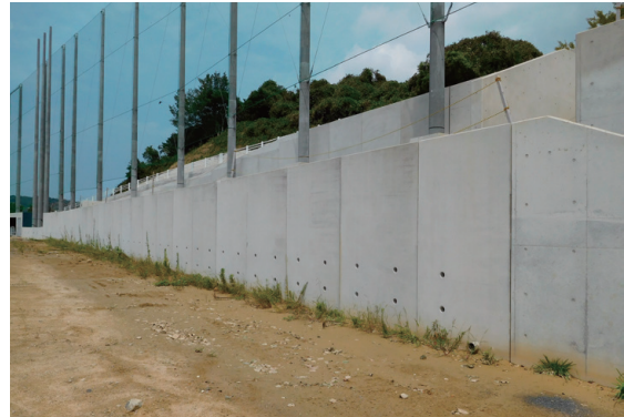
コンクリート擁壁
