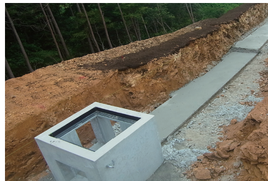
基礎コンクリート
