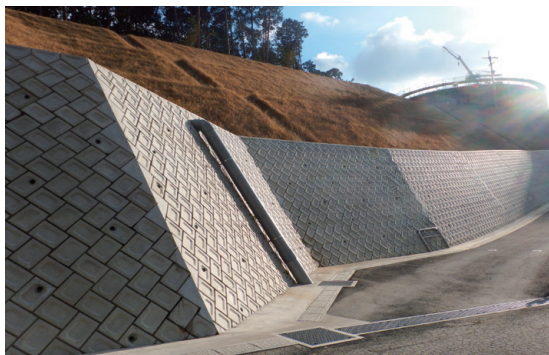
ブロック積の裏込めコンクリート
