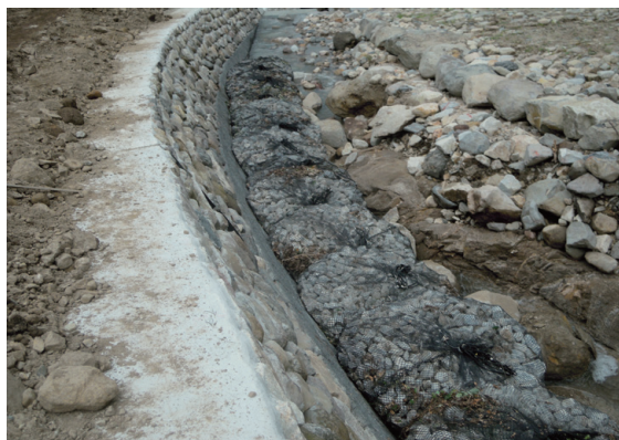
護岸の根固め
