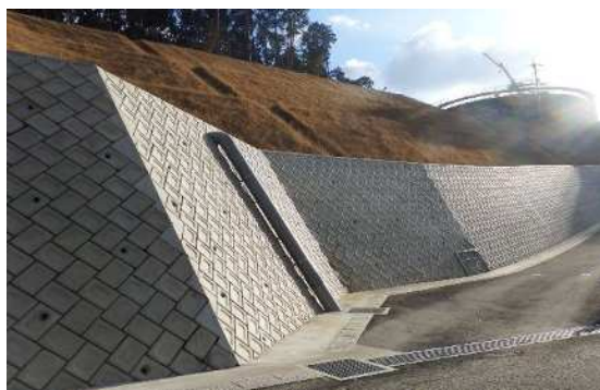
ブロック積の裏込めコンクリート
