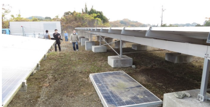
サイト内でのパネル保管状況
