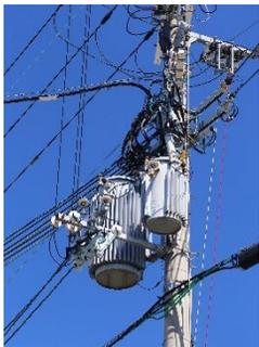
柱上変圧器の修理時に発生する使用済絶縁油を再生処理し、再度絶縁油として利用するための低負荷・低コストなリサイクルシステムを確立を目指しています。
