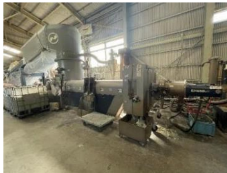
樹脂再生事業者で再生原料化
