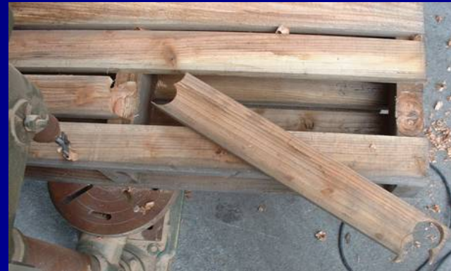
デッキボードが外れた様子
