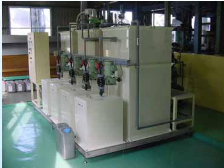
めっき排水分別処理装置試作機
