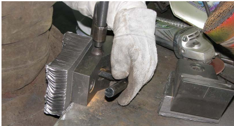
ボルトの取り外し
