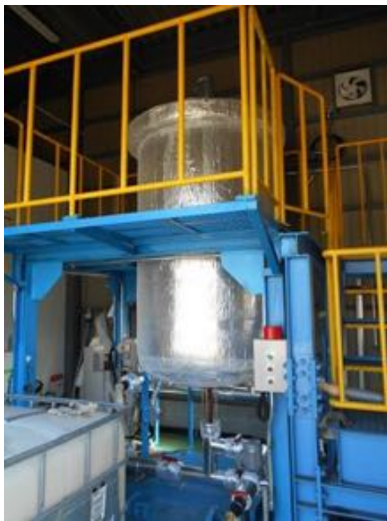
グリセリン水溶液精製 改良工事後の実証実験装置
