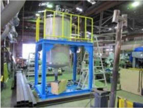
反応槽架台組込
