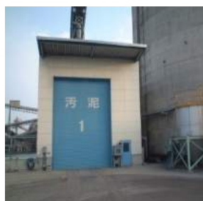
下水汚泥設備
