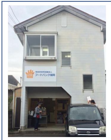
鶴田本部 事務所兼倉庫
