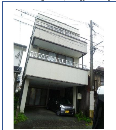
サテライト久留米 事務所兼倉庫
