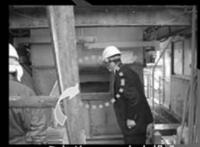
ミキサーへ、人力投入
