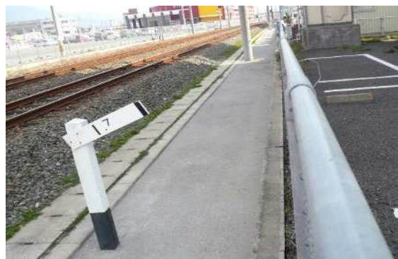
簡易舗装（防草対策）
