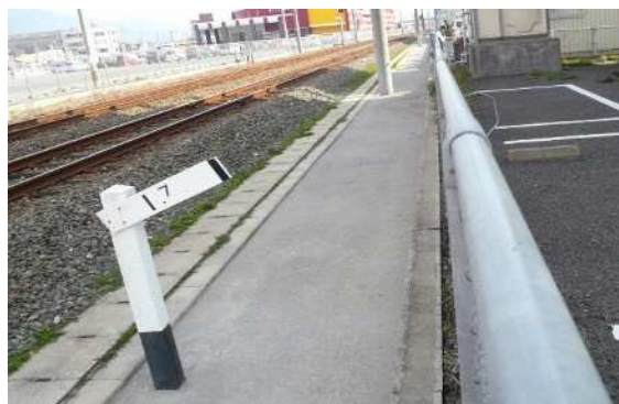
簡易舗装（防草対策）
