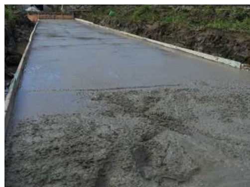
均しコンクリート
