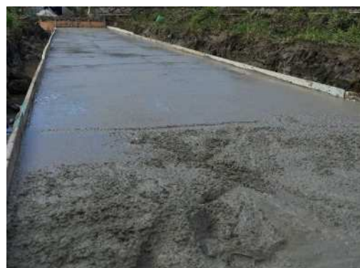
均しコンクリート
